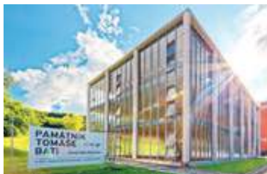
Pamätník Tomáša Baťu – perla svetového funkcionalizmu / The Tomáš Baťa Monument – a functionalist gem
