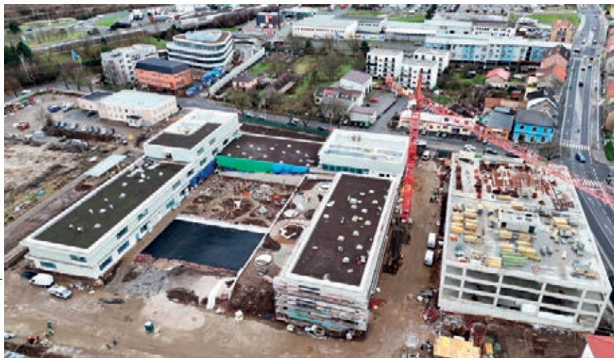
Výstavba základní a mateřské školy VIA, Beroun
